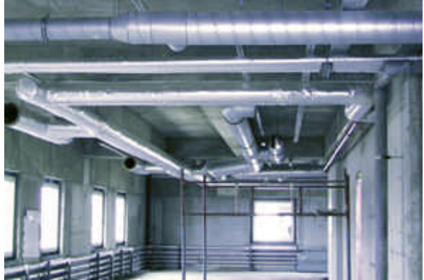
Resim 5.1: Dairesel kanal tesisatı
